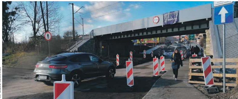
Wiadukt nad ul. Krakowską w Chrzanowie
