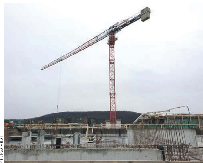
Ogromne maszyny pracują na działkach za dawną Witaminą
