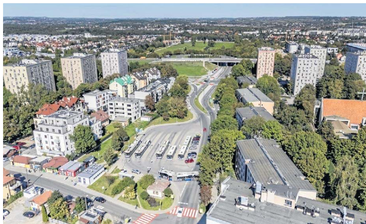
To zaledwie część terenu, na którym zaplanowano przebieg linii tramwajowej z Krowodrzy Górki na Azory w Krakowie
