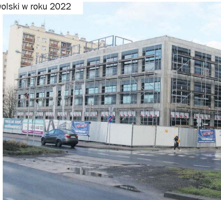
17 stycznia odbyło się uroczyste wmurowanie aktu erekcyjnego pod biurowiec Urzędu Miejskiego w Stalowej Woli. Obiekt będzie dysponował powierzchnią najmu przekraczającą 6 tys. m 2
