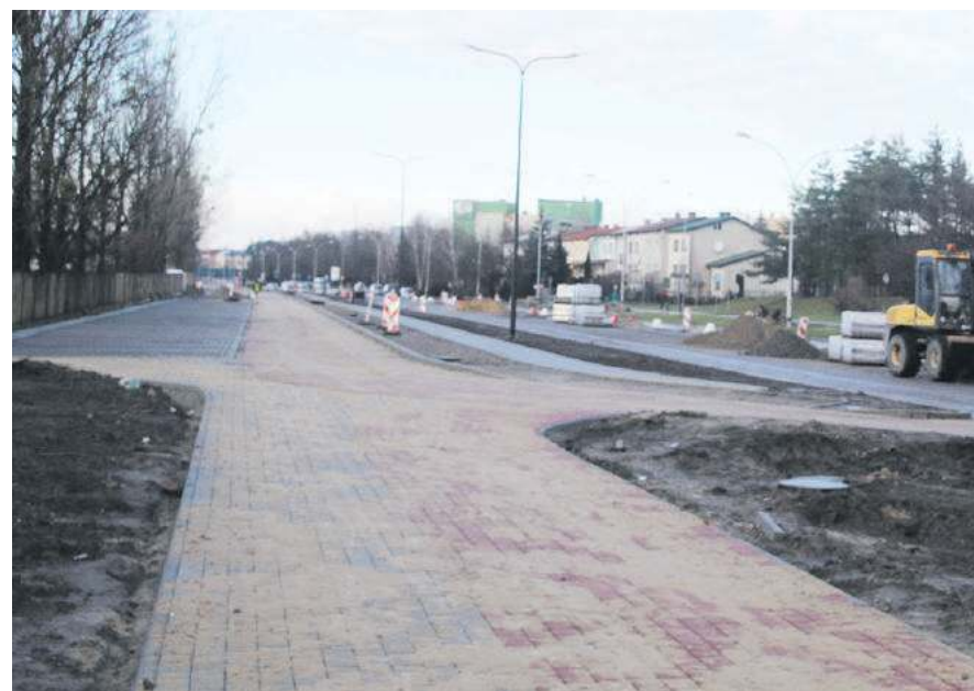
W lutym 2022 r. ruszyły pierwsze prace związane z kompleksową przebudową ulicy Przemysłowej. Modernizacji poddawany jest odcinek o długości ponad 500 metrów od ZBR do ulicy Przemysłowej pod torami kolejowymi
