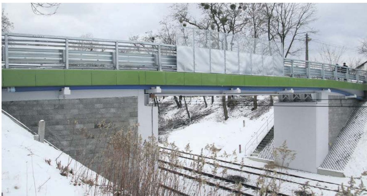
21 stycznia 2022 roku zmodernizowany wiadukt w ulicy Traugutta w Stalowej Woli został oficjalnie otwarty i oddany do użytku mieszkańcom. Zadanie pochłonęło nieco ponad 1,6 mln zł. Inwestycja sfinansowana została w całości ze środków pochodzących z budżetu miasta
