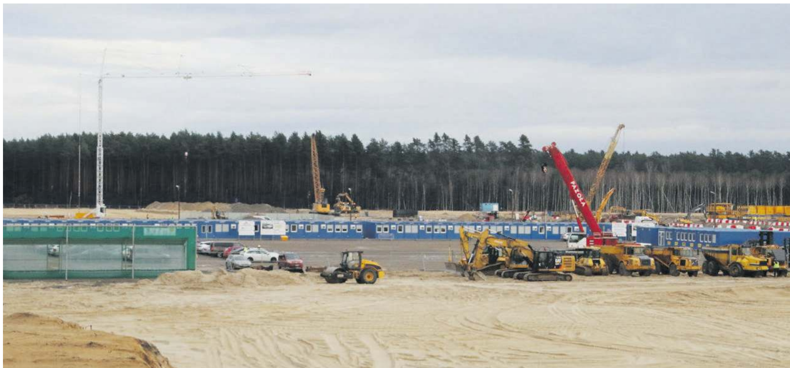
7 lipca na terenie Strategicznego Parku Inwestycyjnego Euro-Park Stalowa Wola rozpoczęła się budowa fabryki za 3 miliardy złotych. Inwestorem jest koreańska firma SK Nexilis. Fabryka w przyszłości, czyli już w 2024 roku, produkować ma folię miedzianą do samochodów elektrycznych. Zatrudnienie znaleźć ma tam około 500 osób
