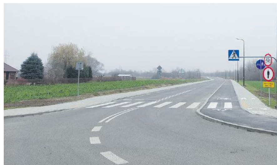
Tego samego dnia co tunel pod torami w Stalowej Woli otwarto również wyremontowany i wybudowany nad obwodnicą Stalowej Woli i Nis
