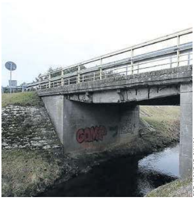
Na rzece Jodłówka w Żabnie wybudowana zostanie nowa przeprawa mostowa
