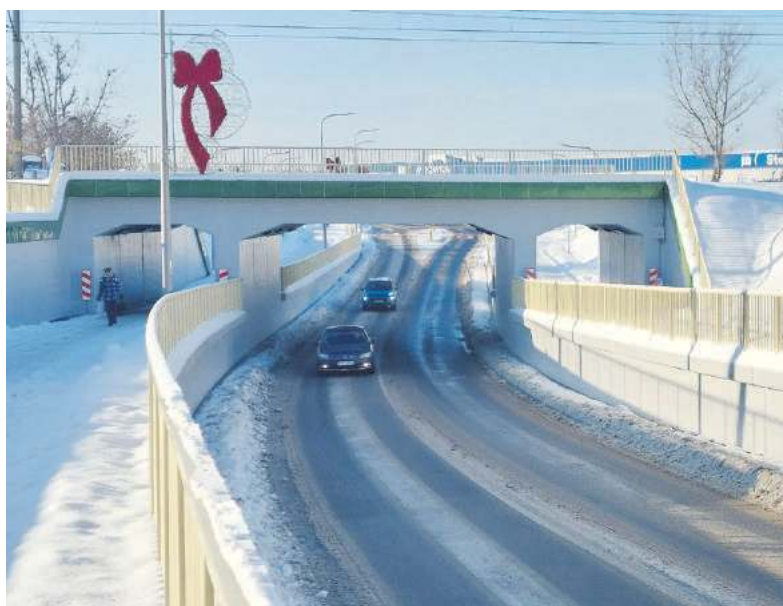
Ta inwestycja zmieniła układ komunikacyjny w Stalowej Woli. Pozwala przejechać tunelem pod torami od ulicy Przemysłowej przez ulicę 11 Listopada do ulicy Okulickiego i dalej do obwodnicy miasta z pominięciem osiedla Rozwadów. Zadanie warte 36 milionów złotych oficjalnie podsumowano 17 grudnia (zdjęcie zrobione w dniu otwarcia)
