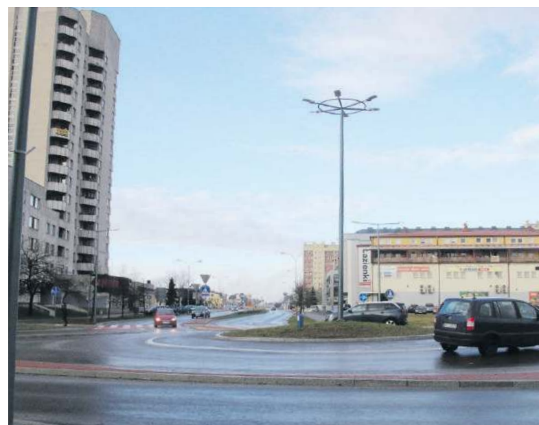
20 stycznia, po gruntownym remoncie, kierowcom oraz pieszym ponownie udostępniono ulicę Popiełuszki w Stalowej Woli. Prace realizowane przez Powiat Stalowowolski trwały ponad 8 miesięcy a ich koszt przekroczył 9 mln złotych. Jedną z charakterystycznych zmian jest zamiana skrzyżowania świetlnego na turborondo
