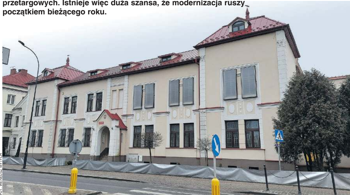
Prace remontowe w dawnym Areszcie Śledczym mają ruszyć początkiem bieżącego roku
