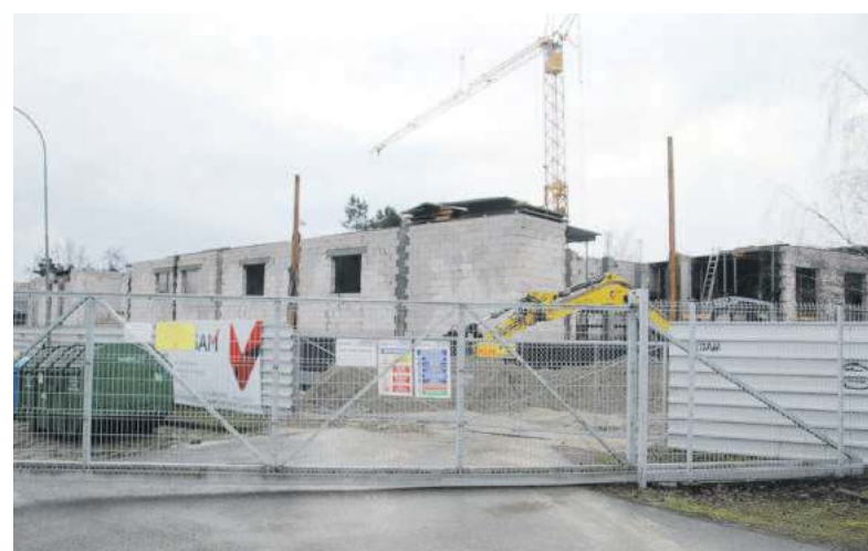
W drugiej połowie 2022 roku rozpoczęły się pierwsze prace przy budowie hospicjum wraz z poradnią medycyny paliatywnej w Stalowej Woli. Obiekt stanie przy ulicy Kwiatkowskiego w sąsiedztwie ambulatorium
