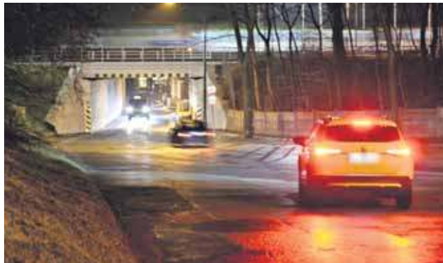
Tunel, wybudowany równolegle do biegnącej pod wiaduktem kolejowym ul. Częstochowskiej, ma przejąć ruch rowerzystów i pieszych
