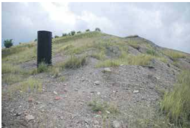
Ostatnie prace na terenie likwidowanych zakładów chemicznych prowadzono w 2011 r.
