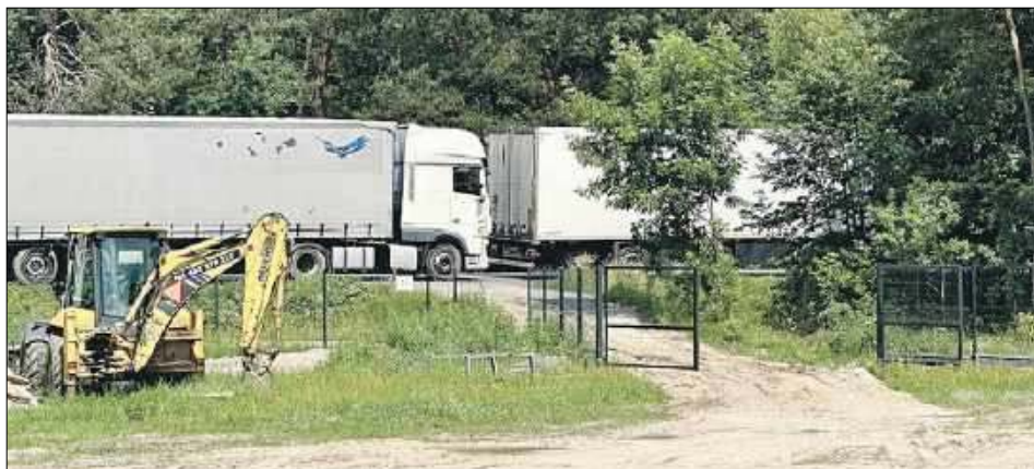
Kolejka ciężarówek blokuje zjazdy do prywatnych posesji przy DK2
