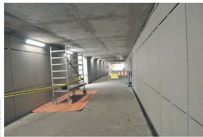
Przejście podziemne na stacji PKP w Trzebini
