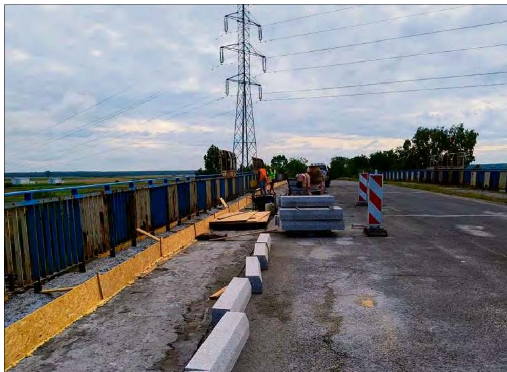
Remont wiaduktu w Przyworach już trwa i potrwa do jesieni.
