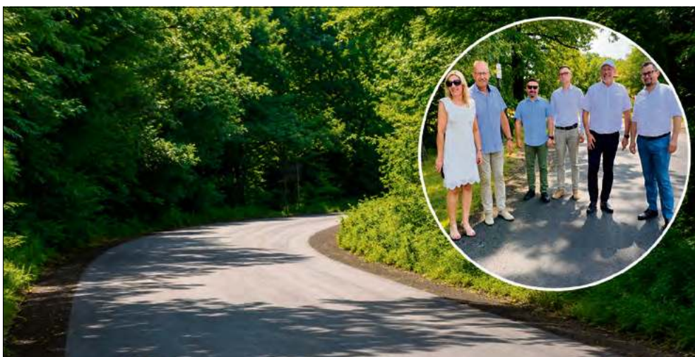
Wyremontowana droga powiatowa w Turawie. Efekt prac osobiście sprawdzili przedstawiciele powiatu opolskiego oraz gminy Turawa.
