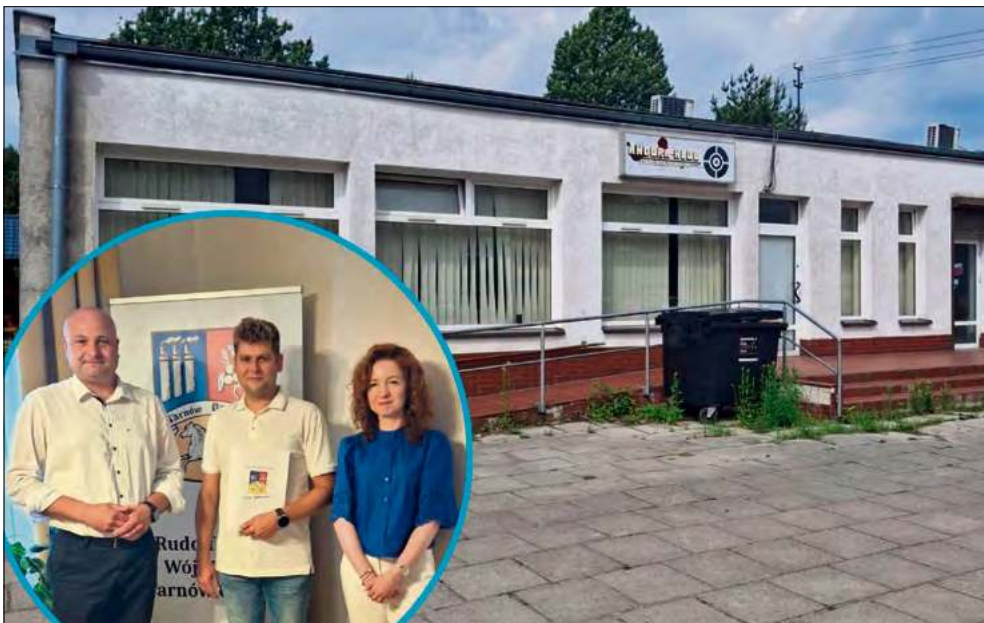
Wójt Rudolf Urban podpisał umowę na przebudowę obiektu przy Osiedlu Zakładowym, w którym powstanie Dom Dziennego Pobytu.
