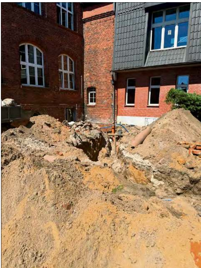
Publiczna Szkoła Podstawowa w Popielowie przejdzie kompleksową modernizację.
