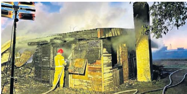
Budynek gospodarczy uległ spaleniu
