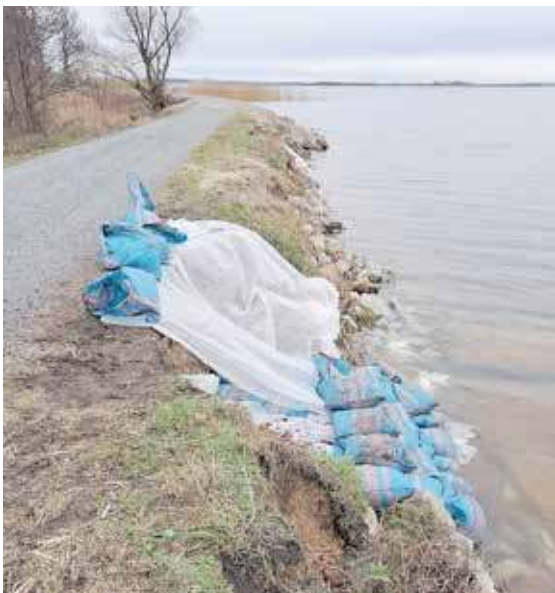
Podstawa wału została wzmocniona (fot. Dariusz Schacht)
