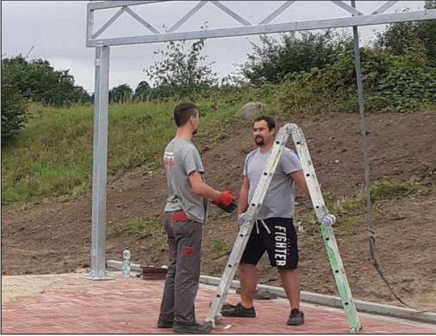
➤ Metalową konstrukcję, na której stanęły trybuny zamontowała firma „Prostar” z Poznania
