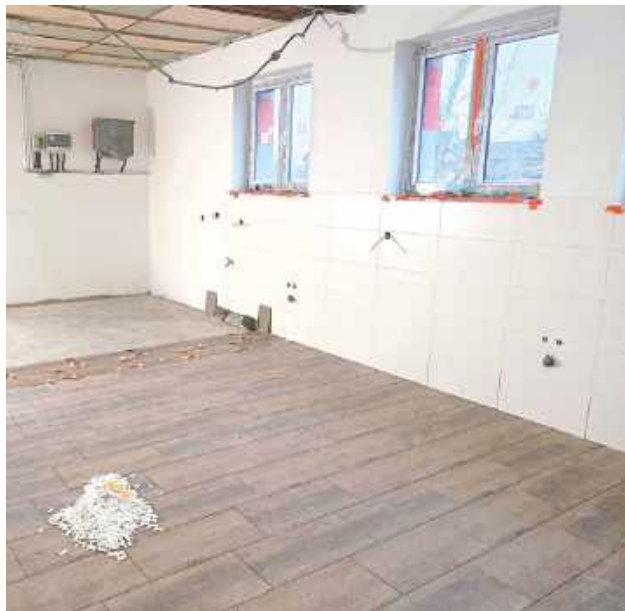
Na takim etapie były prace 18 grudnia 2024 roku. Obecnie do wykonania jest jeszcze instalacja elektryczna
