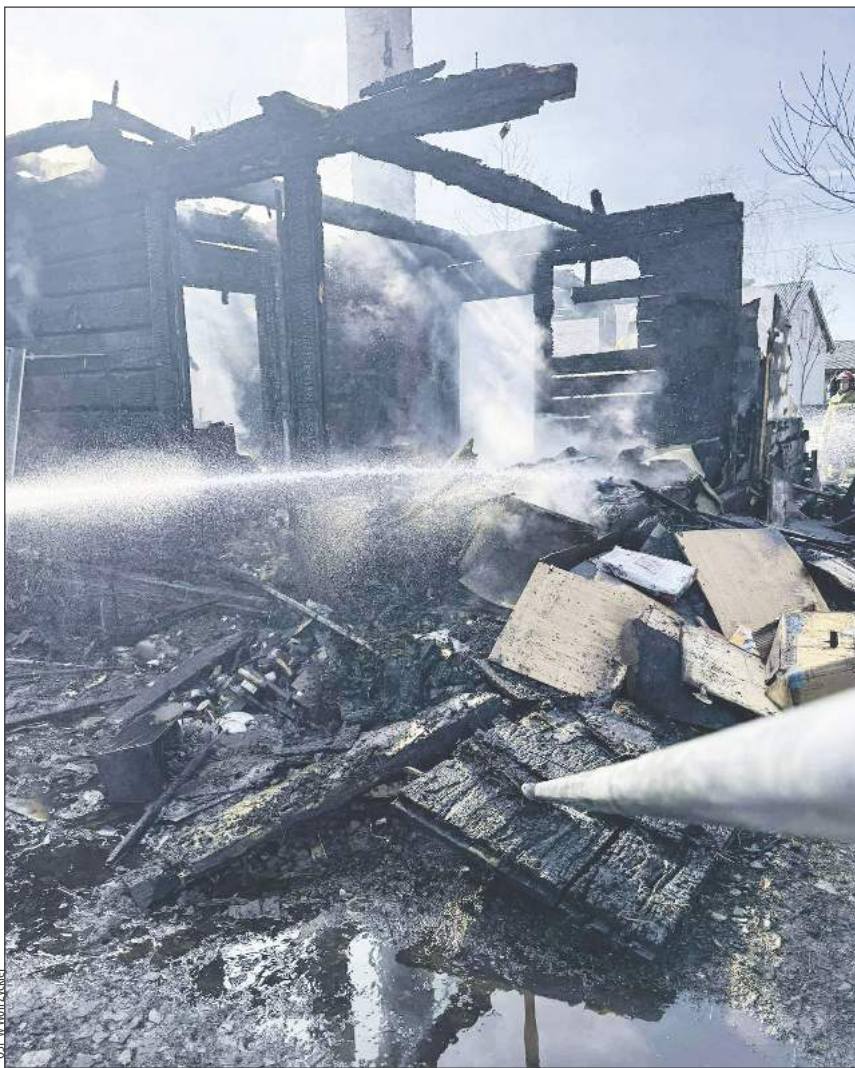
Akcja gaśnicza trwała ponad trzy godziny. Po opanowaniu ognia strażacy prowadzili jeszcze prace rozbiórkowe i dokładnie przelewali pogorzelisko, aby wykluczyć ponowne pojawienie się ognia w drewnianej konstrukcji
