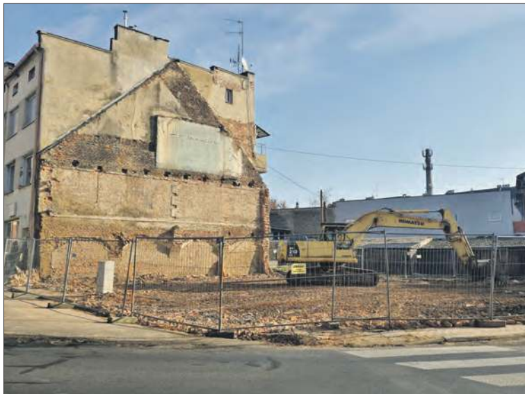
Ulica Piastowska w Głogówku już bez starego budynku
