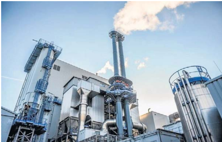
Ekociepłownia została zaplanowana na „tyłach” strefy ekonomicznej, w Chróściku
