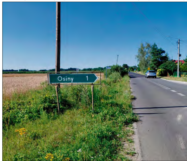
Rozpoczyna się budowa ciągu pieszo-rowerowego na odcinku Dziekaństwo–Domecko.
