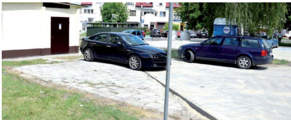
Płytki zostały wyłożone z myślą o altanie śmietnikowej, która ostatecznie nie powstała. Mieszkańcy bloku przy Legionistów 2 parkują tu więc auta, bo stąd mają najbliższe do swoich klatek schodowych
