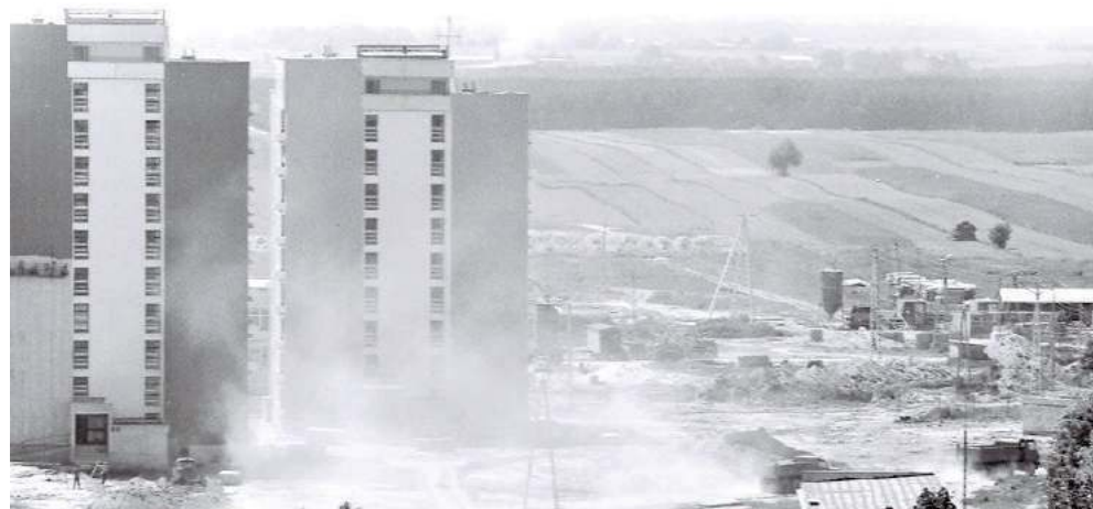
Osiedle Niepodległości. Wieżowce przy - obecnie - Armii Krajowej
