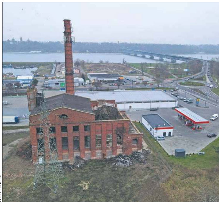
Charakterystycznym elementem dawnej elektrowni jest 55-metrowy komin
