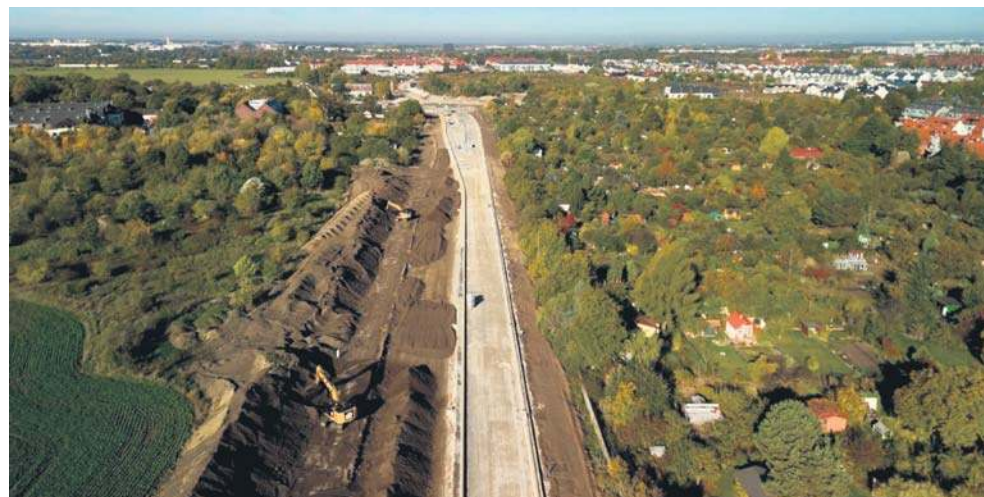
Budowa ostatniego odcinka Wschodniej Obwodnicy Wrocławia zakończy się w 2028 roku
