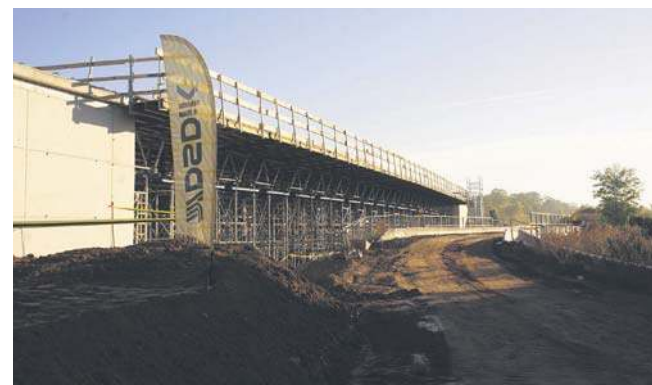
Na trasie ostatniego odcinka Wschodniej Obwodnicy Wrocławia powstają kolejne obiekty inżynieryjne
