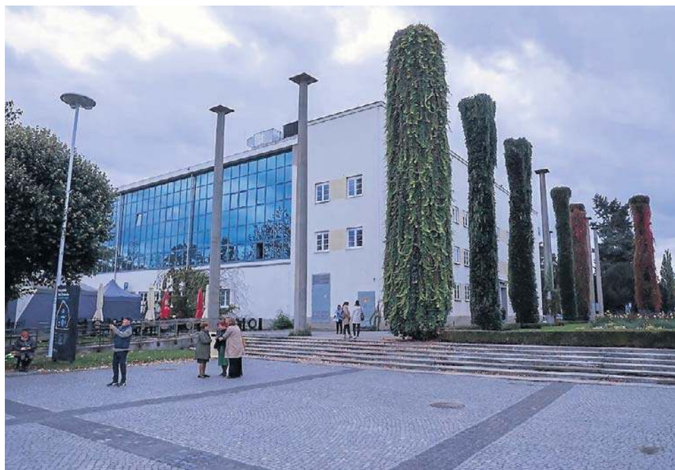
Uwagę kontrolerów zwrócili też plastikowe okna w Hali IASE - powinny być drewniane
