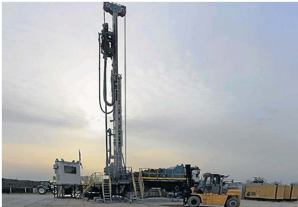
Budowa szybu w Retkowie koło Głogowa
