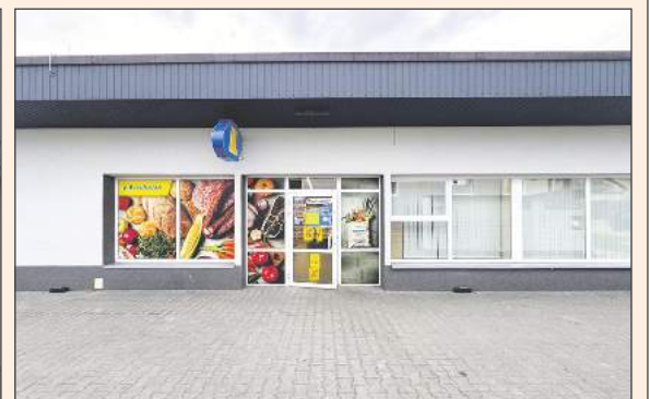
➤ WOLA RĘBKOWSKA: Sklep Lewiatan, ul. Dworcowa 4
