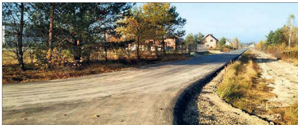
W Maliniu powstanie prawie 400 m drogi gminnej.
