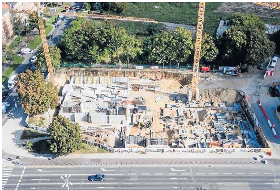
Budynek wrzeszczańskiej pływalni będzie się składał z trzech kondygnacji naziemnych oraz jednej podziemnej. Kubatura obiektu to 25,3 tys. m sześciennych
