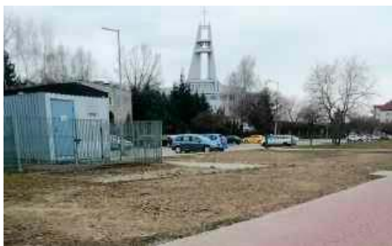
Nowe chodniki w parku Brzeziny II już wymagają naprawy
