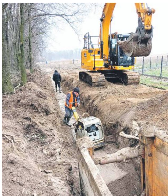
Oleśnica Mała - budowa wodociągu
