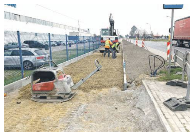
Budowa ścieżki pieszo-rowerowej w Godzikowicach
