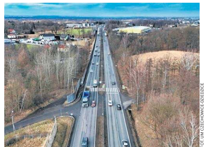
Jeszcze w lutym rozpoczną się prace przygotowawcze do budowy wiaduktów w ciągu DK1
