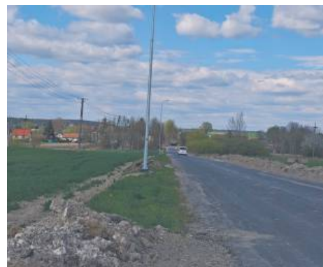
Wola Siennicka - modernizacja oświetlenia ulicznego.
