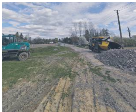
Wola Siennicka - przebudowa drogi -
