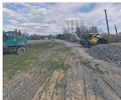
Wola Siennicka - przebudowa drogi -
