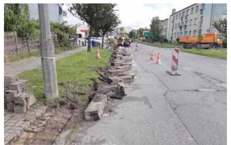
Wymiana krawężników na ul. Grzebskiego
