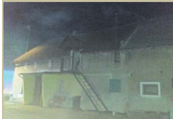
W tym budynku w Rożnowie doszło do pożaru przewodu kominowego (Foto: Strzelin998)
