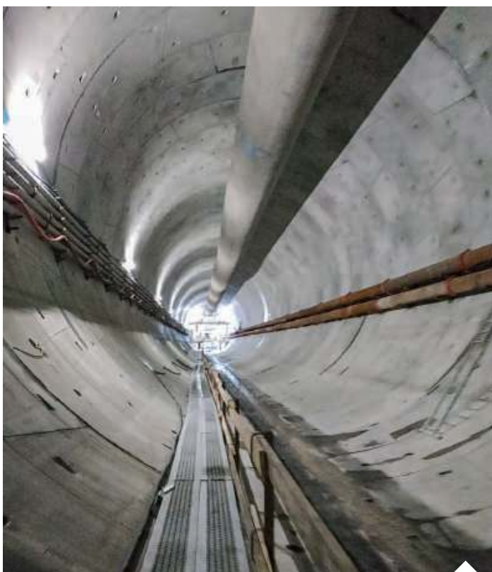
Budowany tunel pod Świną to coś, czego nie potrafiono zrobić przez dziesięciolecie | fot. mat. pras./d
