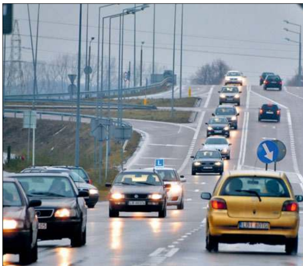
W 2025 roku ruszą prace budowlane na ul. Janowskiej. Ta inwestycja to przegrywka do większego przedsięwzięcia, które wiąże się z połączeniem miasta z autostradowym węzłem w Ciciborze. W planach jest przebudowa wiaduktu i odcinka drogi wojewódzkiej
