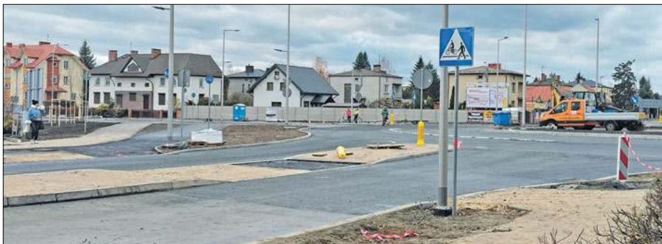
Przejazd ulicą Warszawską już przywrócono, choć prace jeszcze się nie zakończyły
