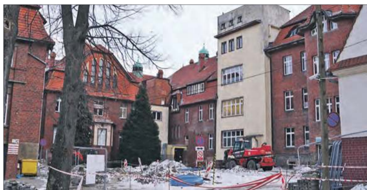
Nowe skrzydło szpitala powstanie na dziedzińcu placówki
