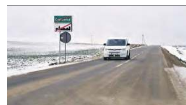
Droga w Czyżowicach przed i po remoncie
