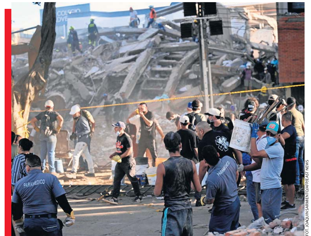
Wolontariusze i ratownicy szukają ocalałych w gruzach zawalonego budynku po trzęsieniu ziemi w Cali.
