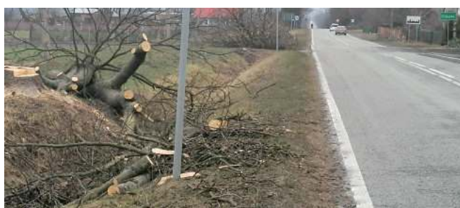
Wycinka drzew to pierwszy etap do budowy ciągu pieszo-rowerowego z Elżbiety do Ożarowa Pierwszego
