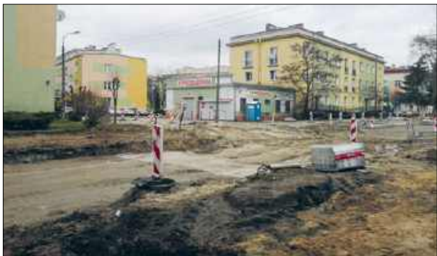
Ulica Kościuszki przechodzi gruntowną przebudowę. Finał prac miasto zapowiada na lipiec
