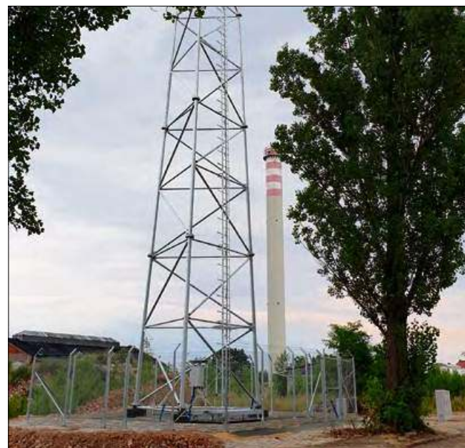
Wieża stanęła na ul. Opolskiej.
