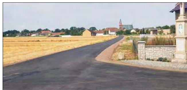
Długo obiecana budowa drogi przy ul. Sadowej w Komornikach została ukończona.
