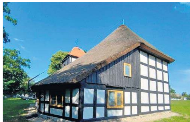
Kościół w Jasieniu pracach renowacyjnych
