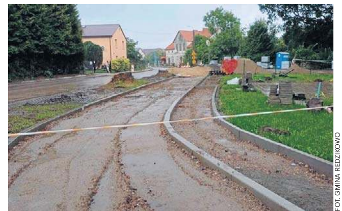
Budowa nowych ścieżek rowerowych w gminie Redzikowo
