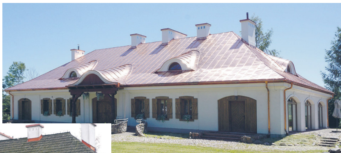
Zajazd po remoncie
