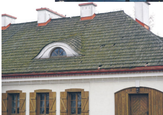
Zajazd przed remontem
