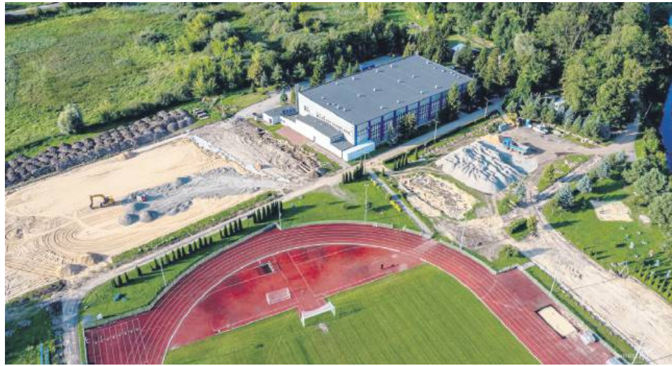
Plac budowy HOSiR został przekazany wykonawcy w maju tego roku.
