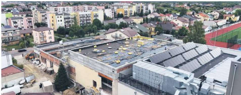
Na zdjęciach z lotu ptaka widać, jak dynamicznie przebiega realizacja inwestycji. Fot. Tomasz Bury
