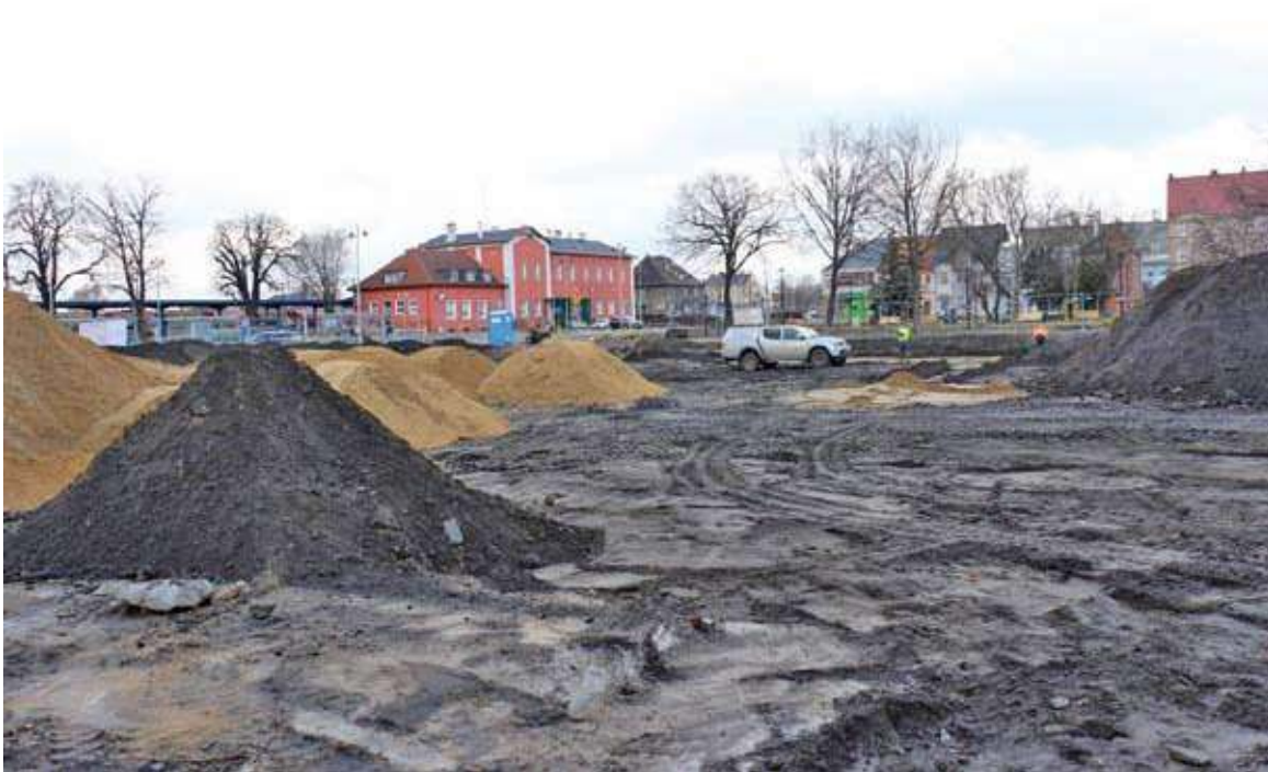
W tym miejscu powstanie nowa hala
