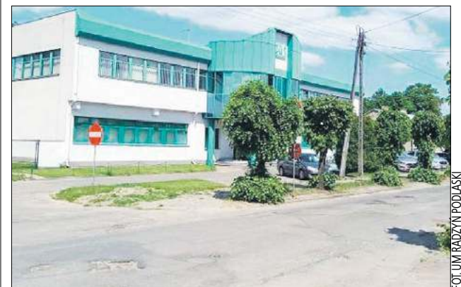
Jest przetarg na modernizację ul. Armii Krajowej. Będzie nowa nawierzchnia i chodniki
