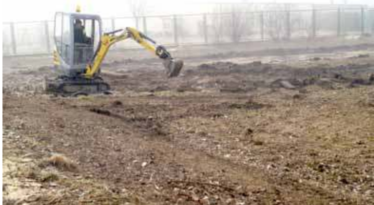
Ruszyły prace związane z modernizacją boiska piłkarskiego przy ul. Ceglanej
