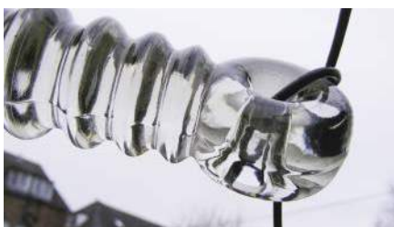
Rysunek 9. Dobra antena to podstawa. Pozioma pętla wokół szyny do wieszania obrazów w wiktoriańskim domu wystarczy, aby odbiornik kryształkowy działał, ale aby uzyskać najlepsze rezultaty, należy zawiesić ją na zewnątrz tak wysoko i długą, jak to możliwe, za pomocą szklanych izolatorów. Znalazłem ten izolator na poboczu nieczynnej linii kolejowej!
