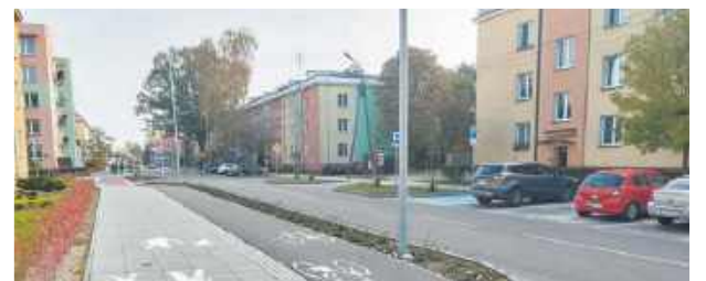
Wyremontowana ulica Kościuszki w Białą Podlaskiej
