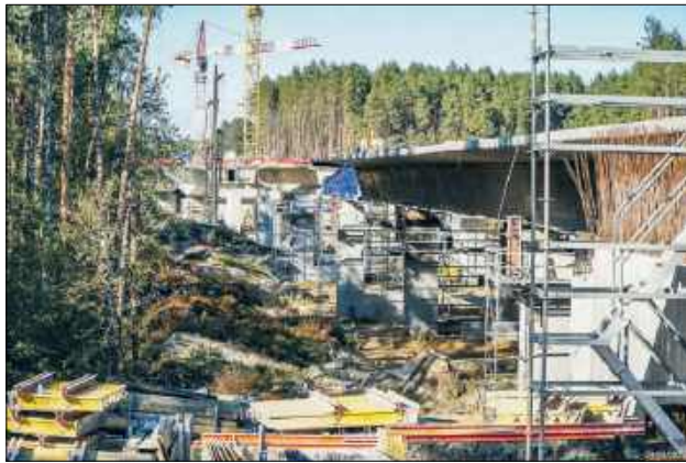
Najtrudniejszym elementem inwestycji jest budowa mostu na Bugu (zdjęcie z 24 września 2025 r.)
