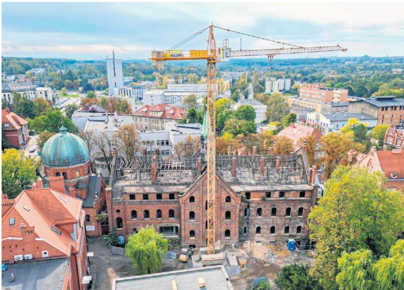
W ramach modernizacji budynku Juliusz zdemontowano pokrycie dachu oraz łączenie połaci dachowych
