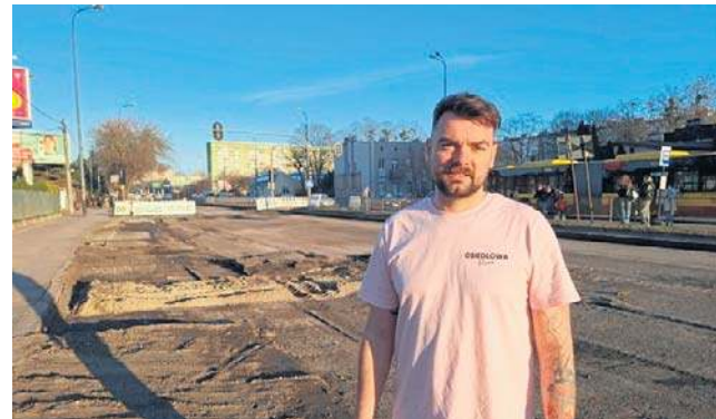
Mateusz Bocheński z Pizzerii Osiedlowej ma zamiast wjazdu na parking wielki rozkop północnej nitki ulicy Broniewskiego
