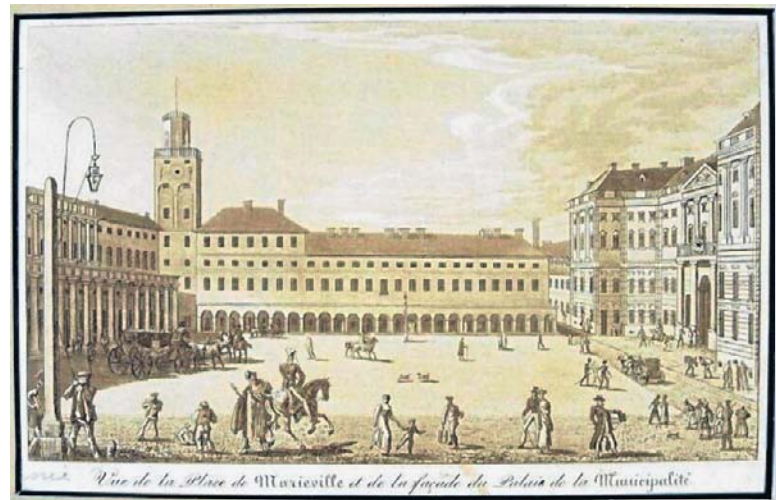
Marywil: widok po przebudowie w okresie Królestwa Polskiego, a przed rozbiórką w 1825 r. – w związku z budową Teatru Wielkiego
