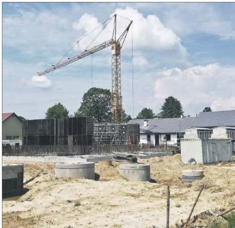
Budowa oczyszczalni ścieków w Jodłowej trwa. (fot. UG Jodłowa)
