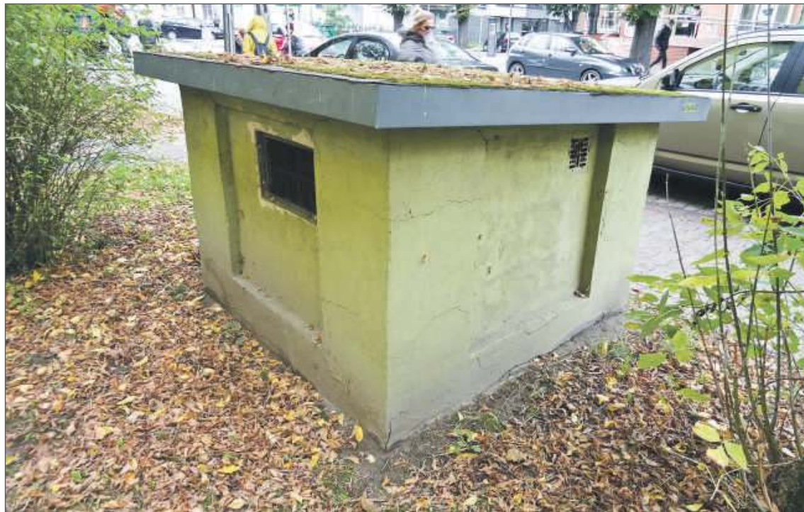
O tym, że w blokach przy ul. Sobieskiego znajdują się schrony świadczą te wyjścia ewakuacyjne.
