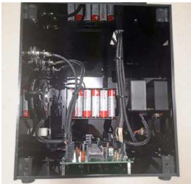
Fotografia 9. Wykonanie połączeń w dolnej części obudowy
