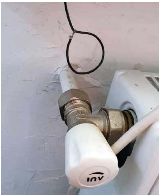
Fotografia 2. Kawalek odstąpiętego metalu skutecznie odprowadza ładunek do ziemi
