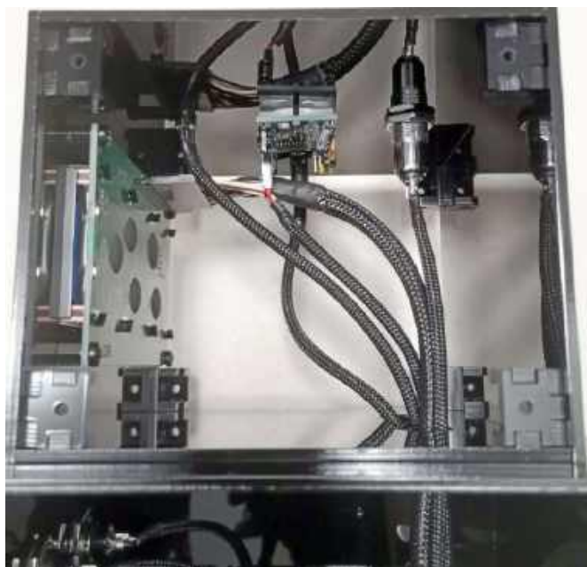
Fotografia 10. Wykonanie połączeń w górnej części obudowy
