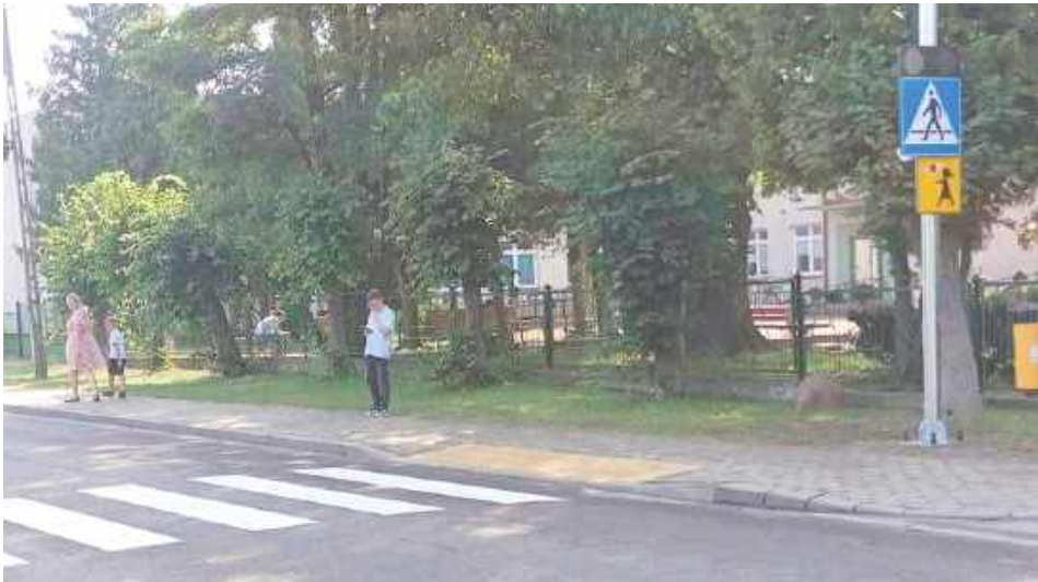
Z początkiem września zakończono budowę nowego, bezpiecznego przejścia dla pieszych przy Zespole Szkół w Czemiernikach, które znacząco podnosi poziom bezpieczeństwa
