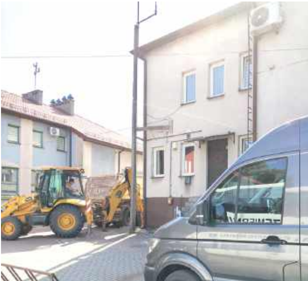
Ruszyła termomodernizacja budynku urzędu miasta
