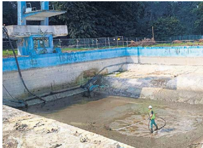
Ważnym było usunięcie wody zalegającej w starej niecce basenowej. Umożliwiło to rozpoczęcie kolejnych prac
