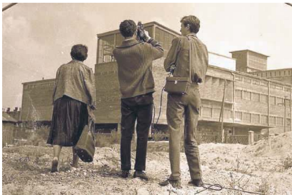
I połowa lat 60. ub. w. Budowa zakładów zbożowych w Zamościu. Fot. Józef Duda. Ze zbiorów APZ
